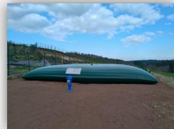
Une capacité de 120 000 litres a été retenue et est maintenant opérationnelle.
