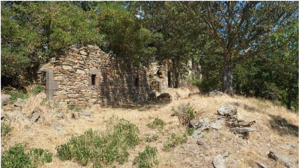
Figure 99 : le bâtiment "B534", façade sud. Cl. : M. Tournadre, 2016.
