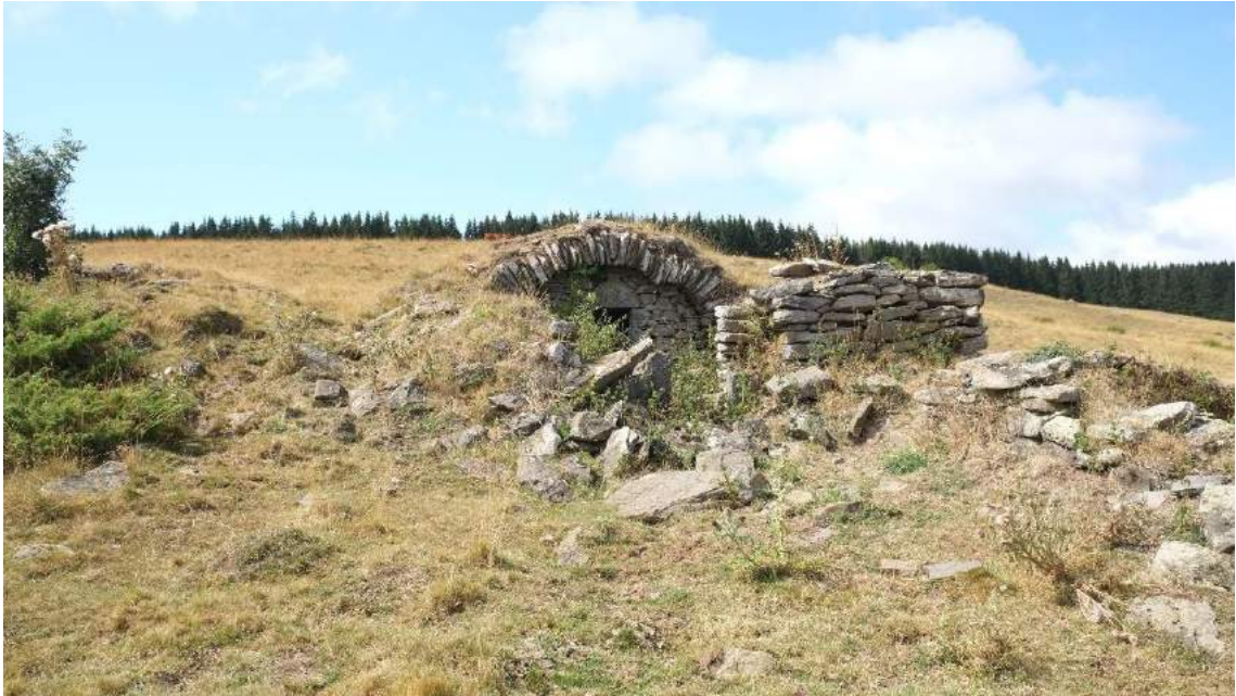
Planche 3 : la structure ST9 et le reste de sa voûte. Cl. M. Tournadre, 2016.
