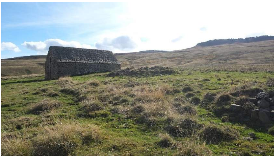
Planche 2 : buron de Parrot, actuellement appelé "les Chemiliers", et les structures en pierre plus anciennes au premier plan. Cl. M. Tournadre, 2016.
