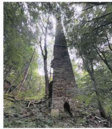
La cheminée de 33 mètres de haut se dresse encore fièrement au milieu des bois, le long du ruisseau de Barthonet.
